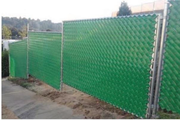
**Figura 11.** Ejemplo de vallado opaco permanente.
