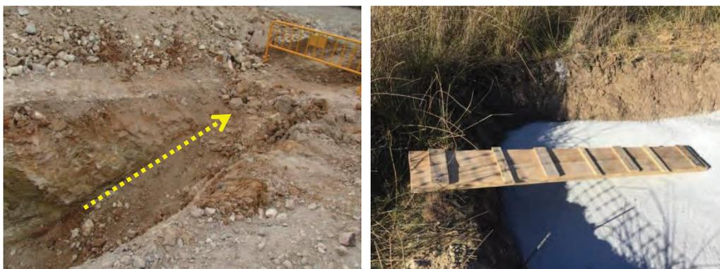
Figura 9. Izquierda: Ejemplo de talud de tierra a modo de rampa de escape en el extremo de una zanja de obra. Derecha: Ejemplo de rampa de escape de fauna de madera en una plataforma de edificación bajo nivel.
